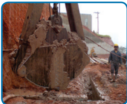
Detalhe da escavação de parede diafragma com uso de polímero
