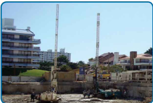
Perfuratrizes, bombas e misturadores para execução de jet grouting - Punta del Este - UY
