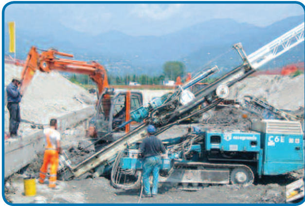
Perfuratriz para execução de colunas de MiniJet®
