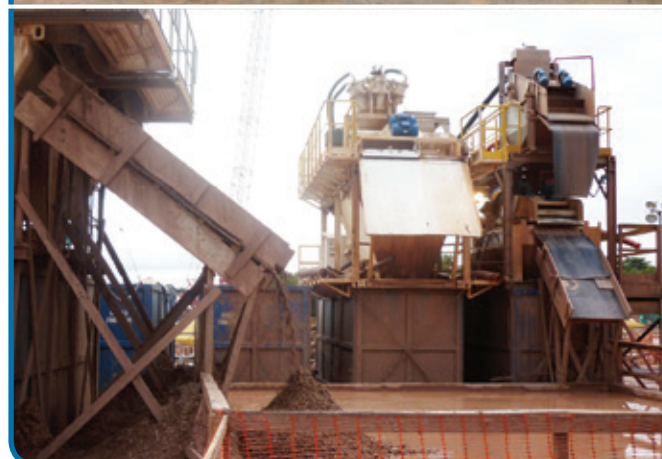
Centrais desarenadoras de lama bentonítica para hidrofresa
