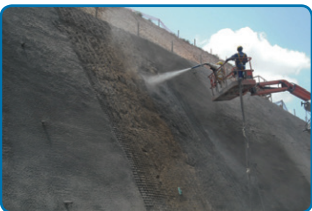
Concreto projetado em Francisco Morato - SP
