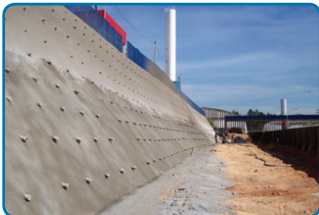
Concreto projetado em solo grampeado - Itapevi - SP
