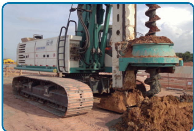
Perfuratriz hidráulica para estaca hélice contínua São Luís - MA
