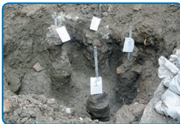
Vista das colunas executadas de MiniJet®
