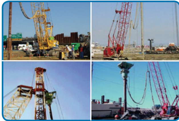
Execução de colunas de brita
