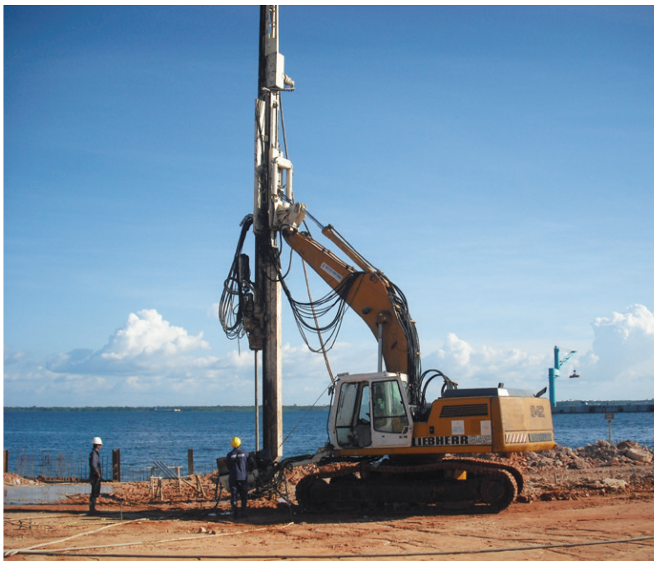
Execução de jet grouting, porto em Manaus - AM
