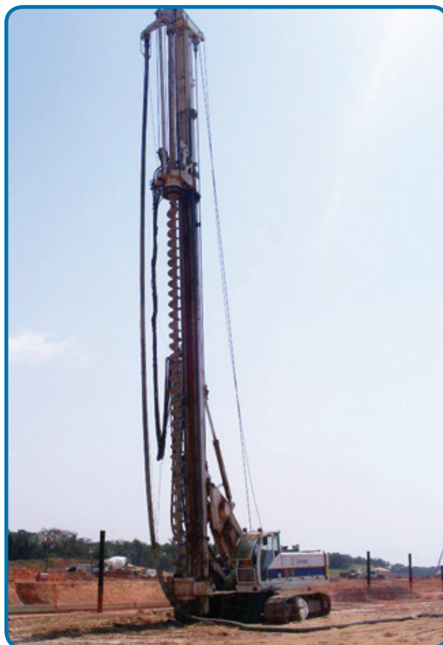
Perfuratriz hidráulica para estaca hélice contínua São Luís - MA
