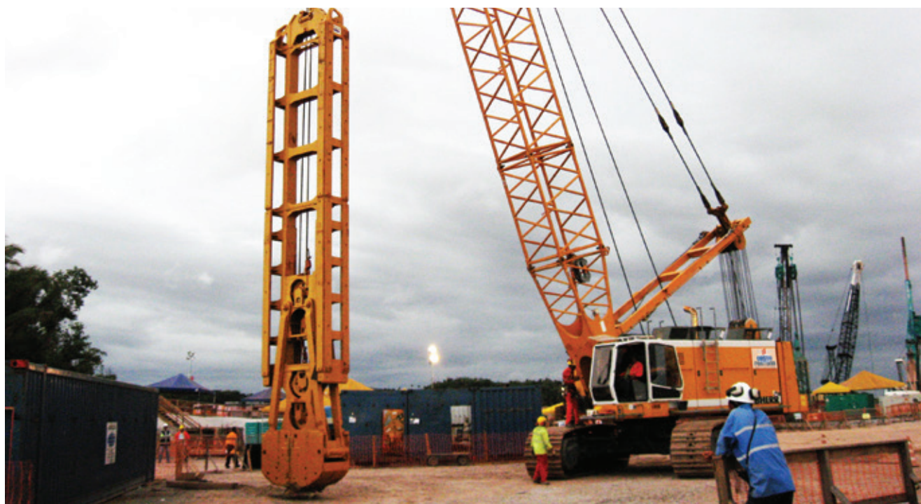
Guindaste sobre esteiras capacidade 120 tf e clam shell mecânico HD de 22 tf para parede de esp. 800 a 1.500 mm com controle de verticalidade
