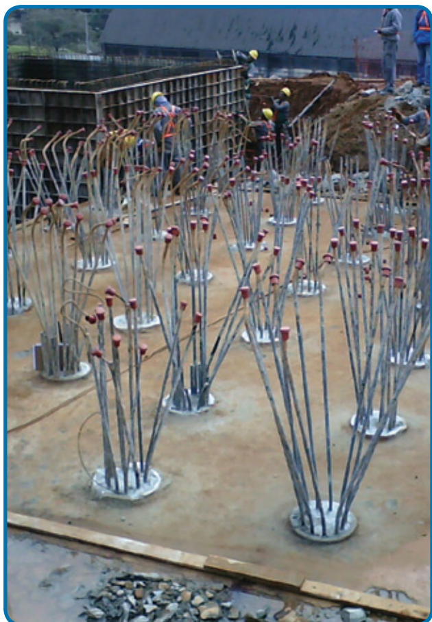
Vista dos blocos de estacas raiz em solo e rocha executadas Rio Branco - PR
