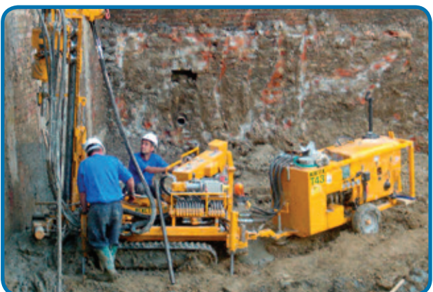
Perfuratriz hidráulica para execução de colunas de MiniJet®
