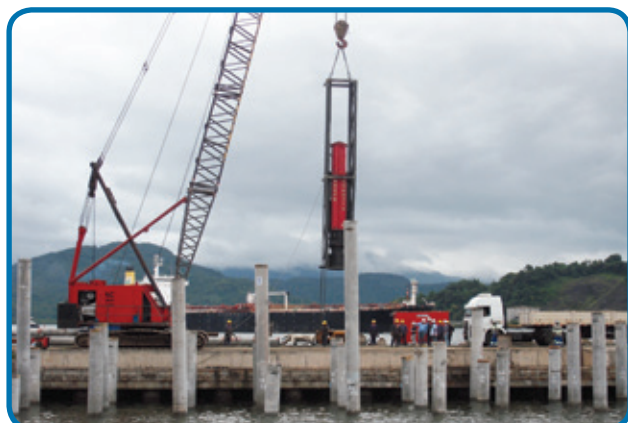
Equipamentos hidráulicos para cravação de estacas pré-fabricadas
