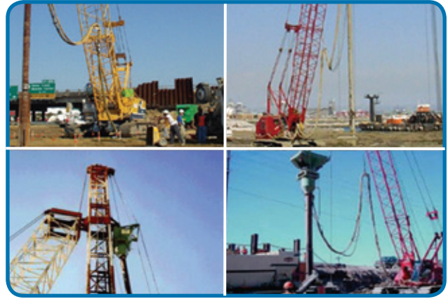
Ejecución de columnas de grava
