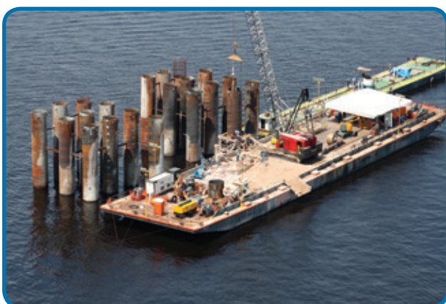
Puente suspendido sobre el Río Negro - apoyo central Manaus - AM
