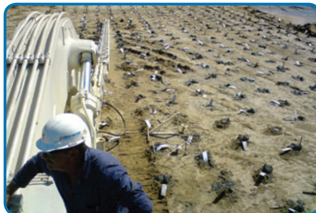
Detalle de geodrenos anclados - Palhoça - SC
