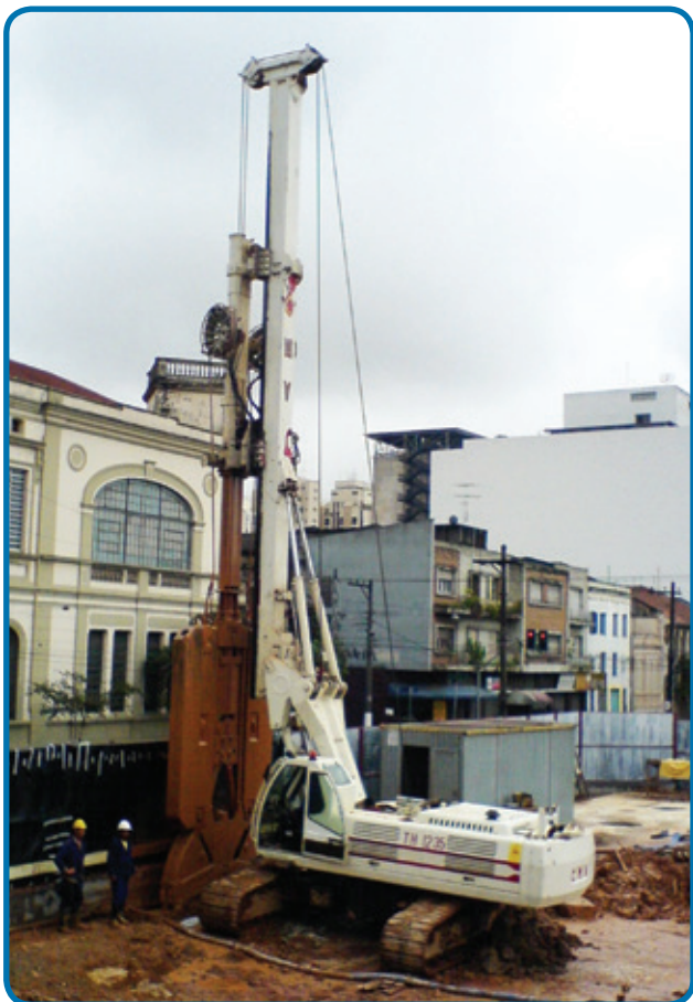
Ejecución de muro diafragma mediante uso de clam shell hidráulico en el centro de SP - SP
