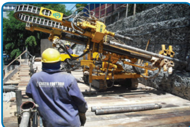
Perforadora hidráulica para ejecución de tirantes en roca mediante uso de martillo de fondo
