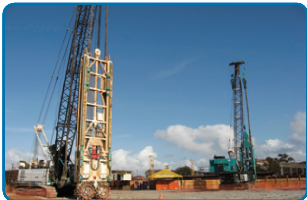
Muro diafragma en roca mediante uso de hidrofresas Casagrande® FD60 y FD30
