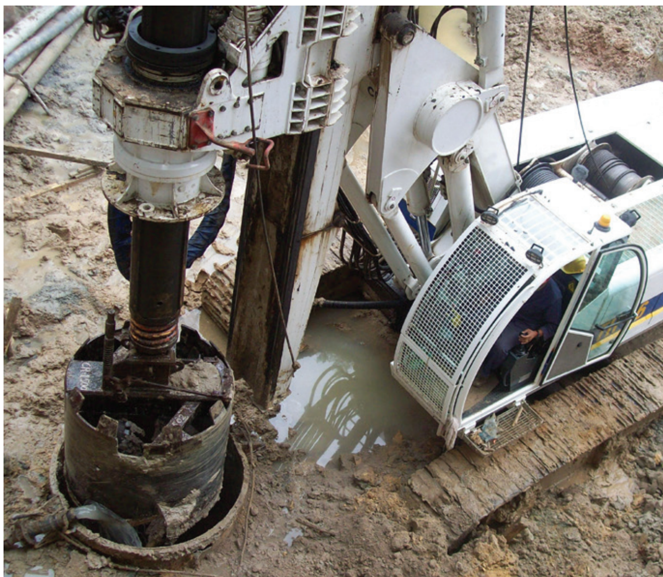
Detalle de la ejecución de pilote excavado - Curitiba - PR
