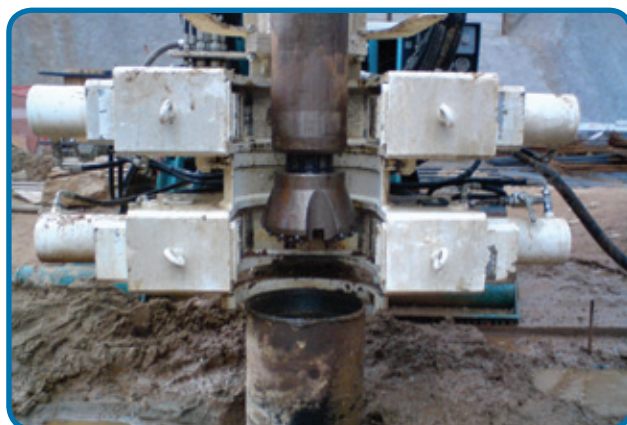
Detalle del martillo de fondo para ejecución de pilote raíz en roca
