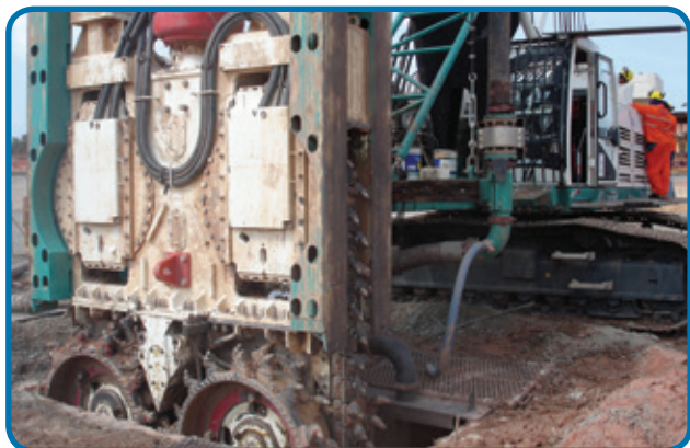
Excavación de panel diafragma en roca. Espesor 1m y profundidad 36m
