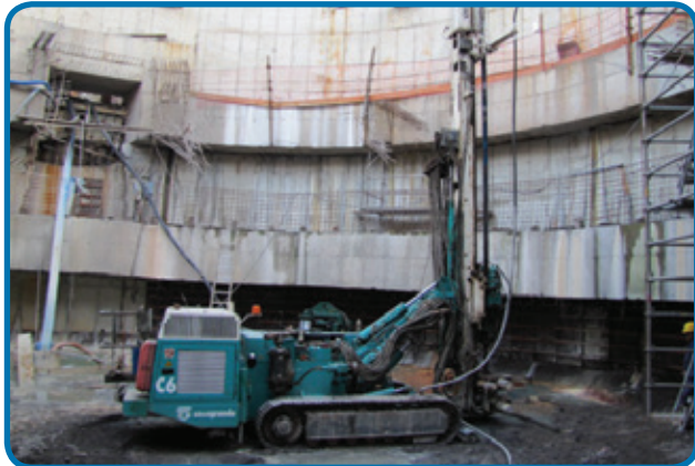
Ejecución de columnas de jet grouting Cubatão - SP
