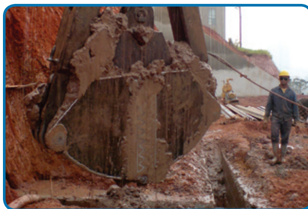
Detalle de excavación de muro diafragma mediante uso de polímero
