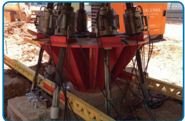
Prueba de Carga Estática sobre pilote barrete embutido en roca granítica mediante hidrofresa hasta 1440tf
