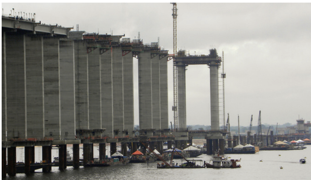
Ejecución de pilotes excavados mediante el uso de camisa metálica perdida y fluido estabilizante Puente sobre el Río Negro, Manaus-AM
