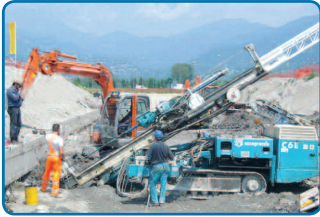
Perforadora para ejecución de columnas de MiniJet®
