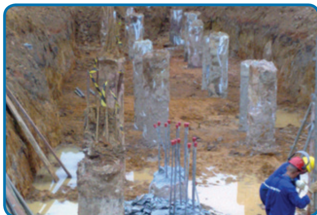
Vista de los pilotes hélice continua en fase de nivelación
