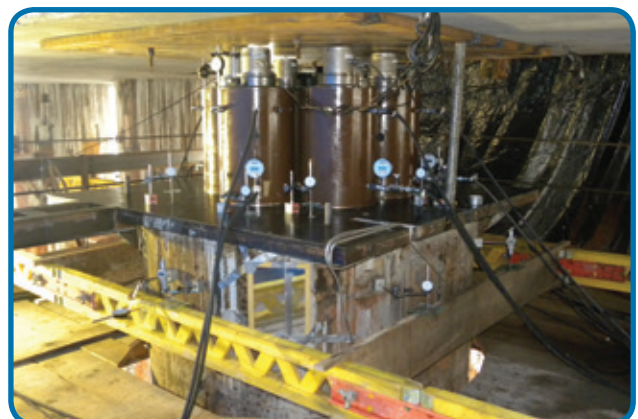
Prueba de carga estática en suelo con tirantes de reacción para 3600 tf - Manaus - AM
