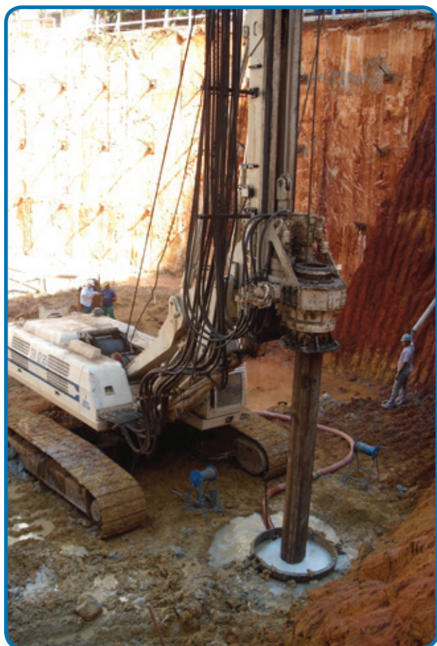
Ejecución de pilote excavado mediante uso de polímero
