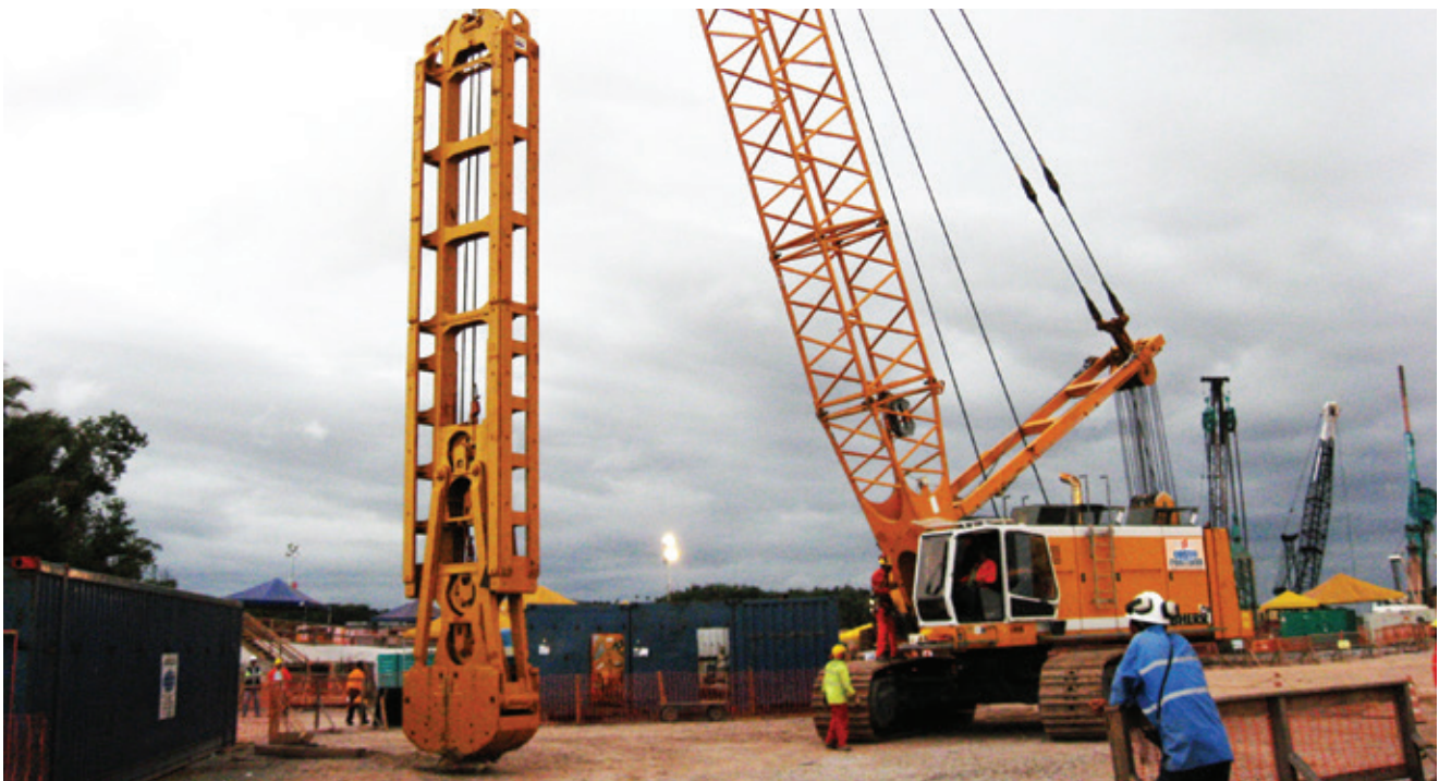
Grúa sobre estacas capacidad 120 tf y clam shell mecánico HD de 22tf para pared con espesor 800 a 1.500mm con control de verticalidad
