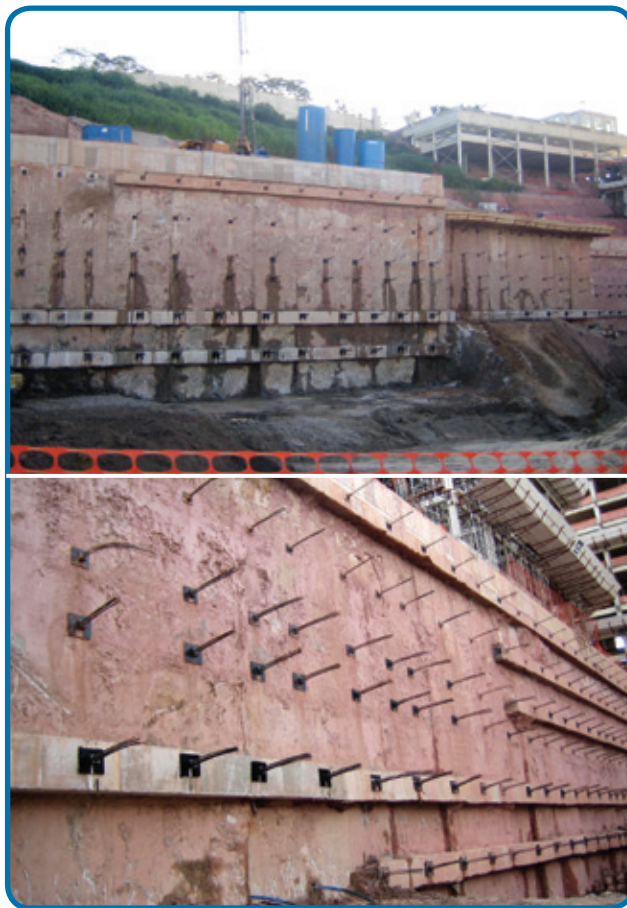
Detalles de muro diafragma y tirantes de cables de acero ejecutados
