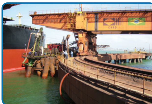
Recuperación del dolphin de atraque Porto de Tubarão - ES
