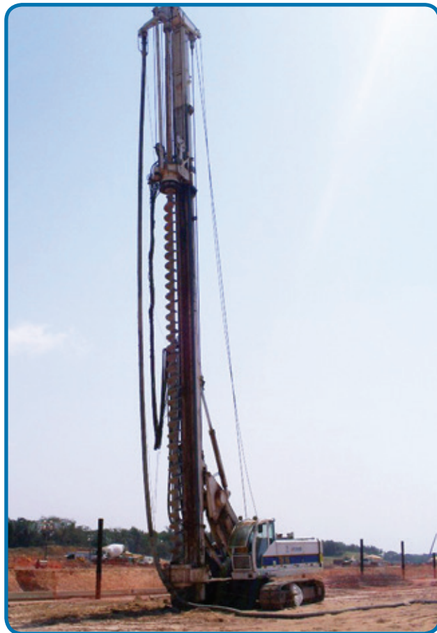
Perforadora hidráulica para pilote hélice continua São Luis - MA
