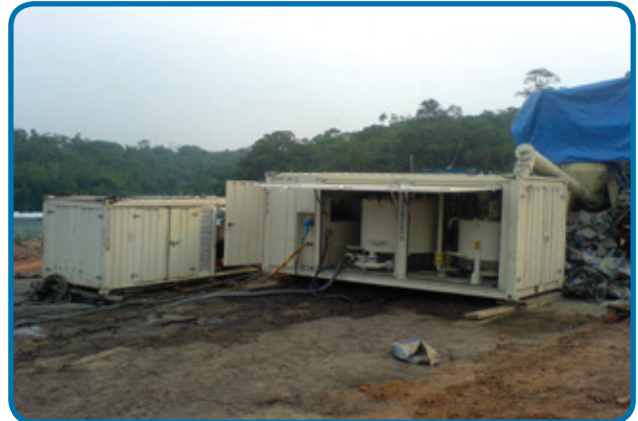
Vista del equipo de mezcla y bomba de alta presión para jet grouting - PCH en Sapezal - MT
