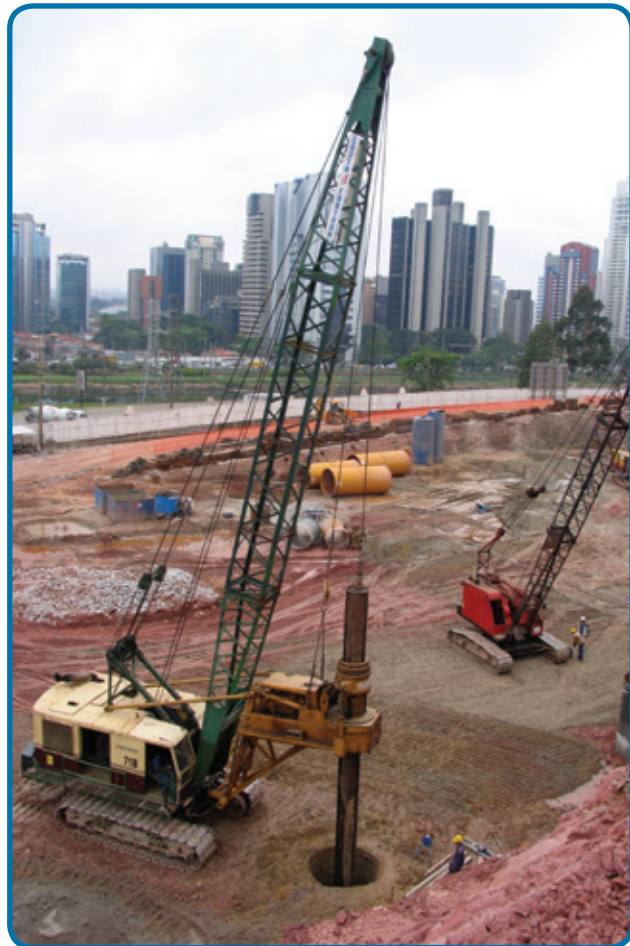
Pilotes excavados en la orilla del río Pinheiros, emprendimiento residencial y comercial, São Paulo - SP
