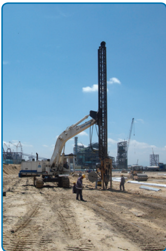
Anclaje de geodreno con vibro-percutor Santa Cruz - RJ
