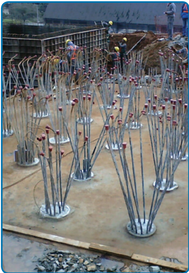
Vista de los bloques de pilotes raíz en suelo y roca ejecutadas - Río Branco - PR
