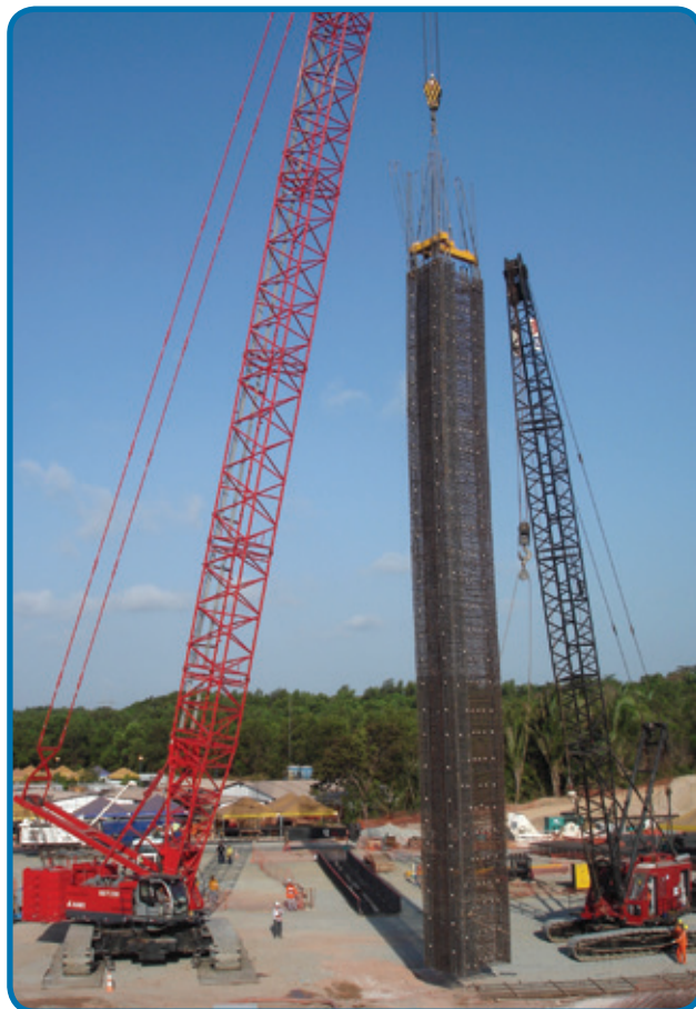
Elevación de armadura con 36m y peso de 40ft para muro diafragma en roca con espesor de 1m con contrafuertes
