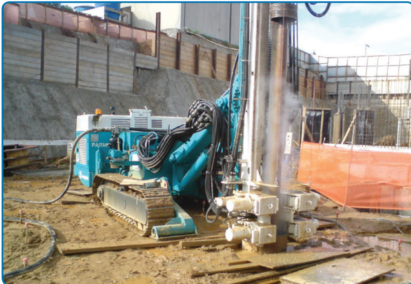
Pilotes raíz en suelo y roca mediante uso de perforadora, revestimiento y martillo de fondo - Barueri - SP
