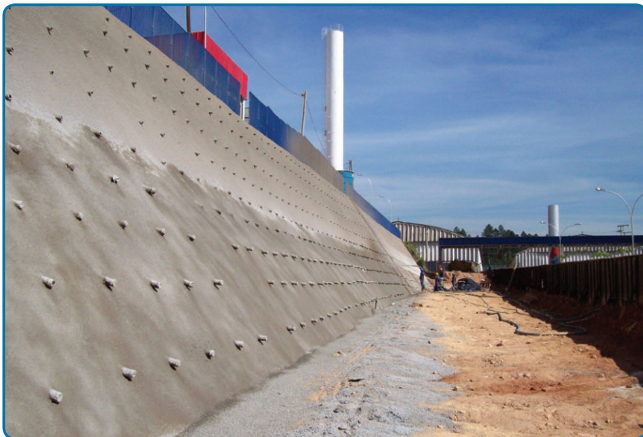
Cemento proyectado en suelo claveteado - Itapevi - SP
