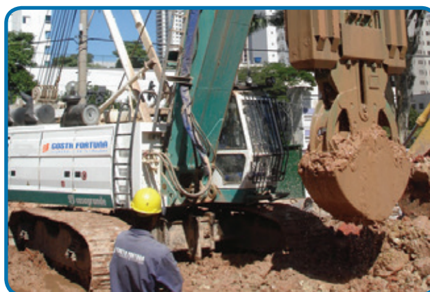
Ejecución de muro diafragma mediante uso de clam shell hidráulico en Belo Horizonte - MG
