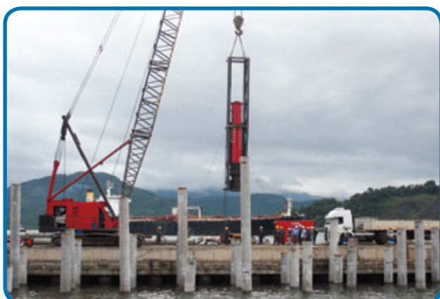
Equipos hidráulicos para anclaje de pilotes prefabricados
