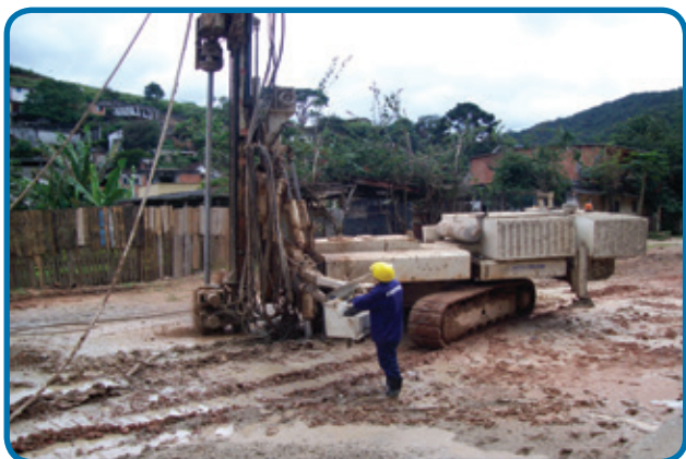
Ejecución de columnas de jet grouting Río de Janeiro - RJ
