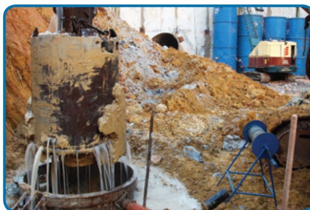
Detalle de la ejecución de pilote excavado mediante el uso de polímero
