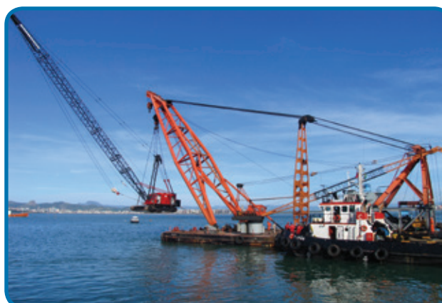
Aplicques especiales en Obras Marítimas y Fluviales
