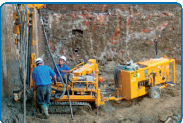
Perforadora hidráulica para ejecución de columnas de Minijet®
