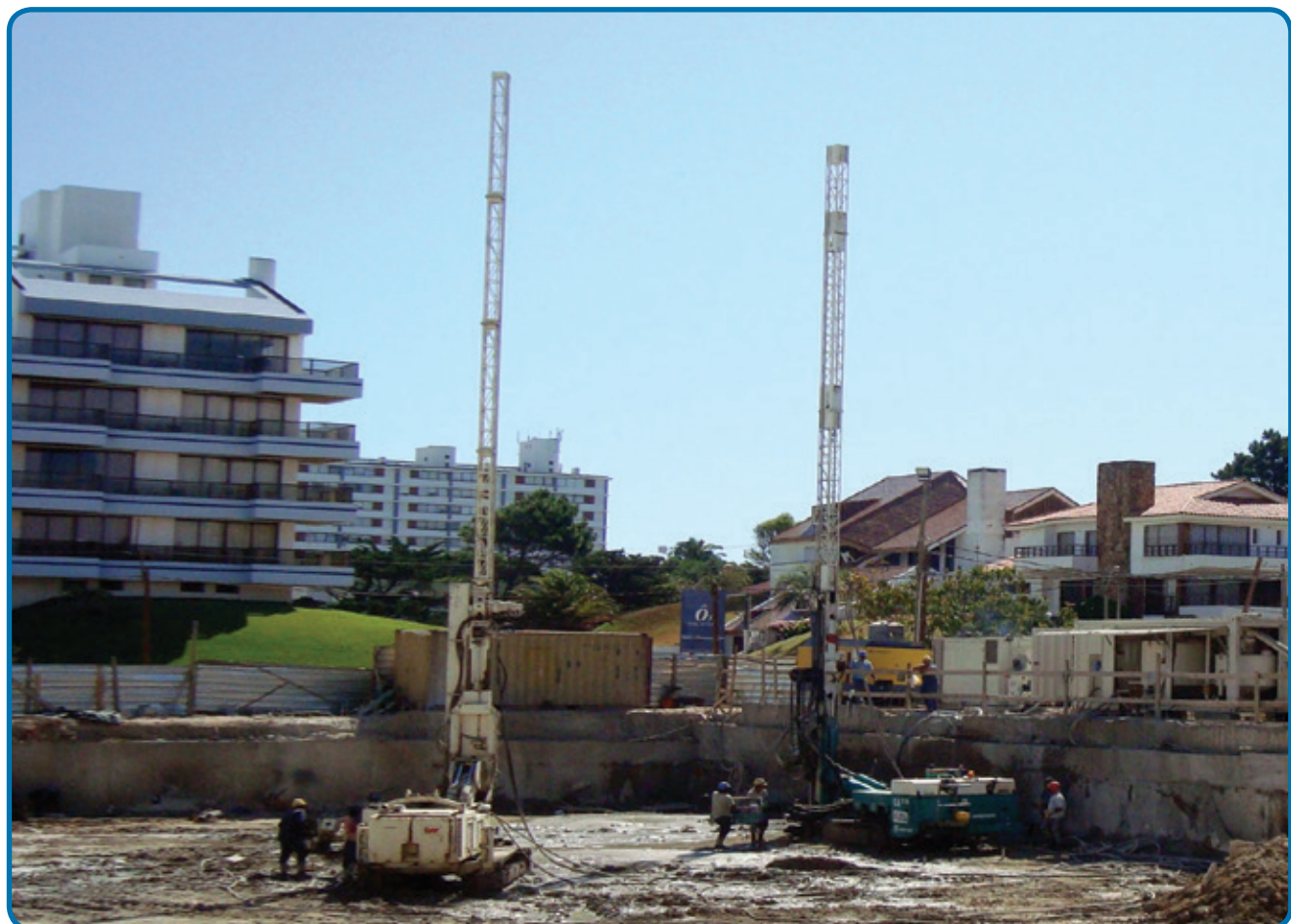
Perforadoras, bombas y mezcladores para ejecución de jet grouting - Punta del Este - UY
