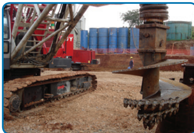
Detalle de la excavadora de pico para pilotes excavados en roca
