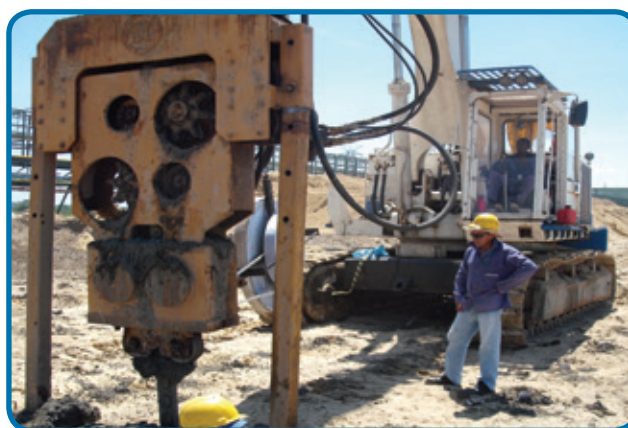
Vista de la maquinaria especial usada para anclaje de geodrenos para el paso de capas compactas
