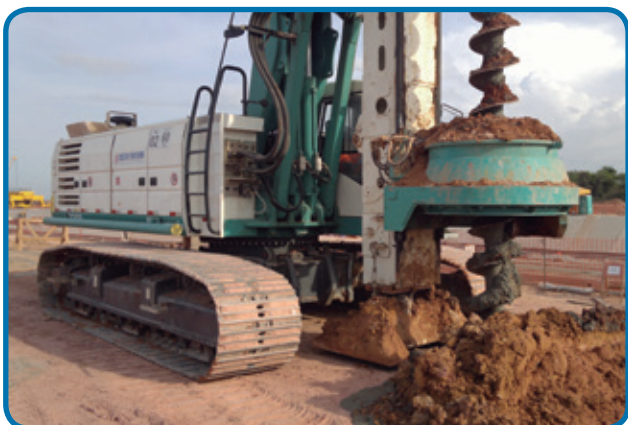
Perforadora hidráulica para pilote hélice continua São Luis - MA
