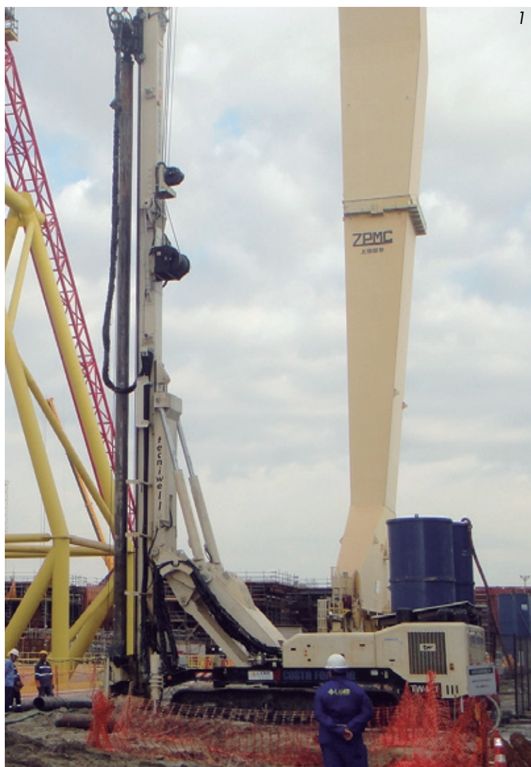
1 - Execução das estacas raiz em rocha
