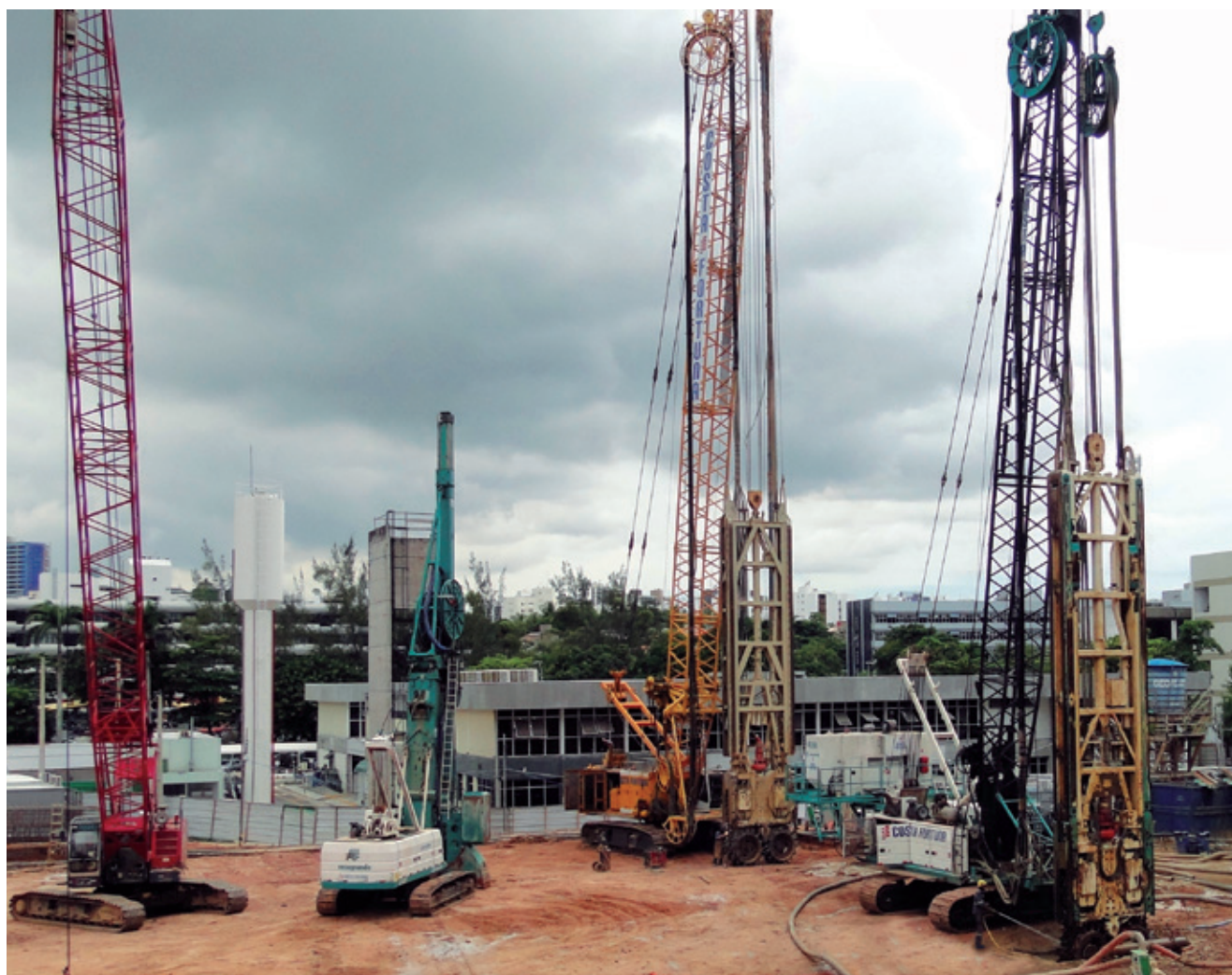
Conjuntos de guindastes e hidrofresas para execução de estacas barrete em rocha sã.
