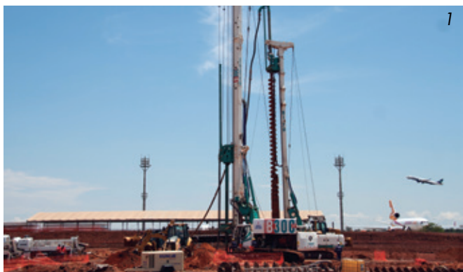
1 - Vista dos equipamentos Casagrande B300XP e B125.
