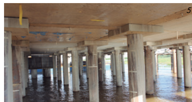
1 - Vista geral da obra do apoio central da torre de transmissão. 2 - Vista da limpeza interna das estacas via air lift. 3 - Estacas cravadas da torre principal. 4 - Colocação de pré-laje nas estacas cravadas. 5 - Vista inferior da laje finalizada.
