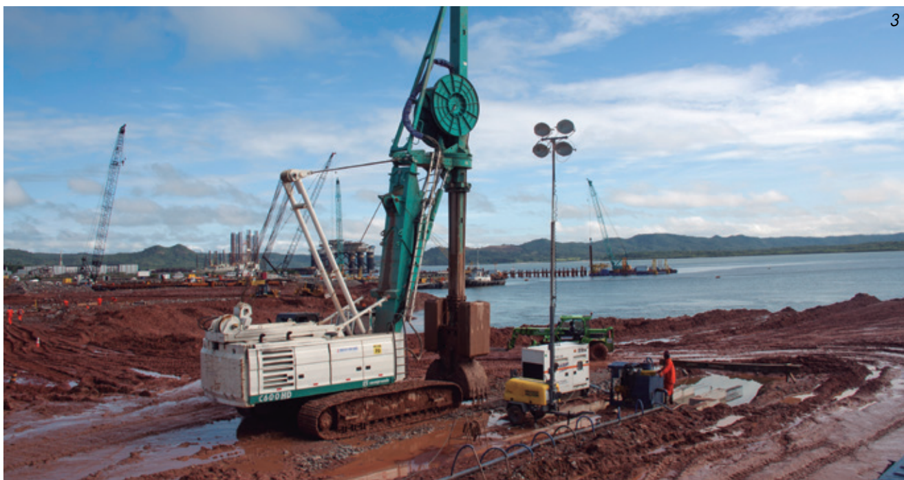
1 e 2 - Execução de parede diafragma em rocha com uso de Equipamentos Casagrande e Liebherr. 3 - Execução de parede diafragma com uso de clam shell hidráulico com torre e haste telescópica, monitorada eletronicamente.
