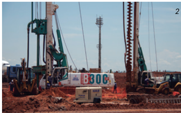
2 - Execução de estaca escavada e hélice contínua.
