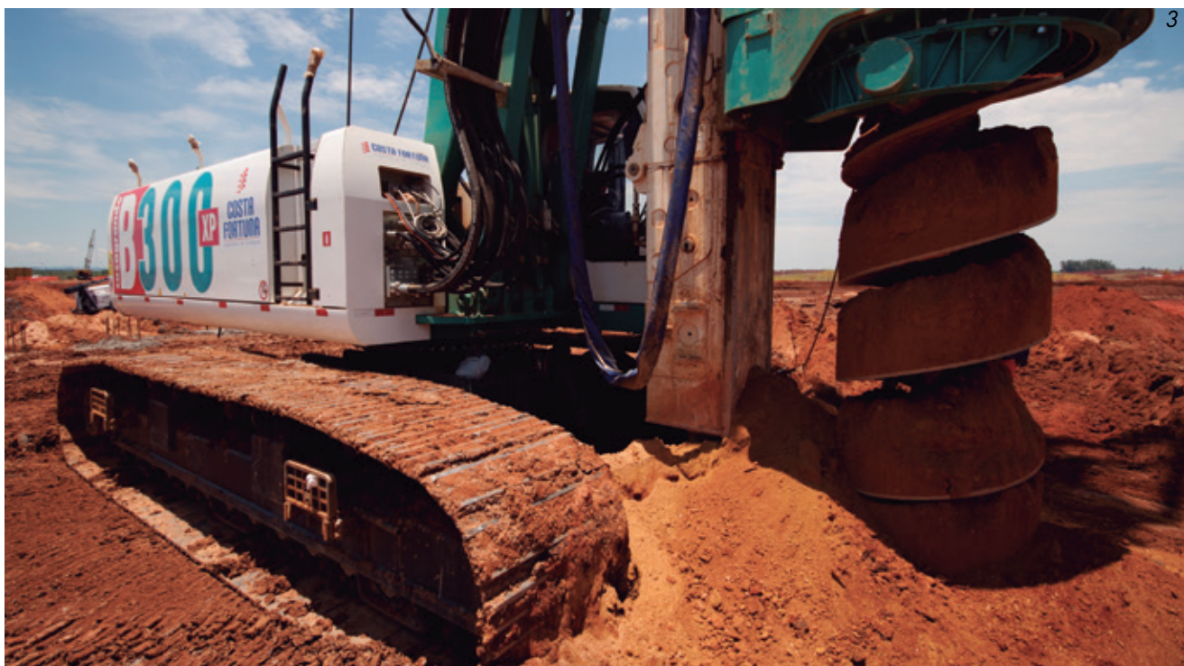
3 - Detalhe da execução de hélice contínua.
