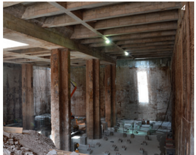
1 - Hidrofresas FD60 e FD30. 2 - Detalhe da hidrofresa FD60 em execução. 3 e 4 - Vistas do termino das escavações e exposição das paredes diafragma e barretes em plena atividade estrutural.
