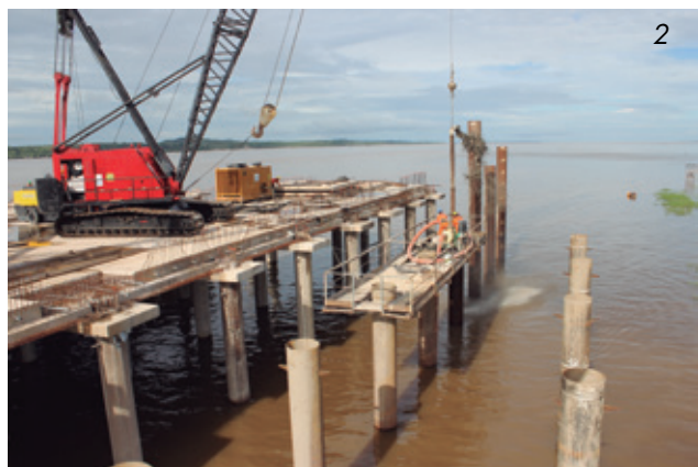
1 - Vista geral da obra do apoio central da torre de transmissão. 2 - Vista da limpeza interna das estacas via air lift. 3 - Estacas cravadas da torre principal. 4 - Colocação de pré-laje nas estacas cravadas. 5 - Vista inferior da laje finalizada.
