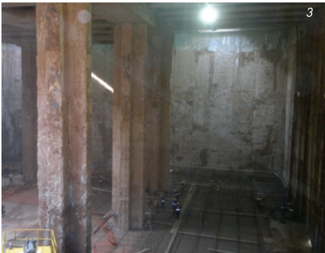
1 - Hidrofresas FD60 e FD30. 2 - Detalhe da hidrofresa FD60 em execução. 3 e 4 - Vistas do termino das escavações e exposição das paredes diafragma e barretes em plena atividade estrutural.
