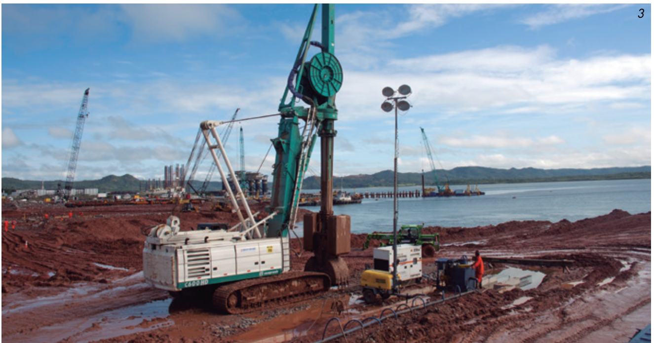
1 y 2 - Ejecución de muro diafragma en roca con uso de Equipos Casagrande y Liebherr.
