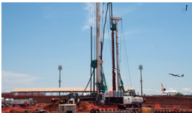
1 - Vista de los equipos Casagrande B300XP y B125
