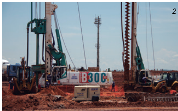
2 - Detalles de la ejecución de hélice continua.
