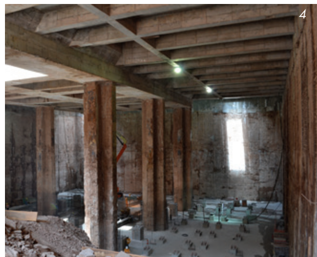
3 y 4 - Vistas del fin de las excavaciones y exposición de los muros diafragma y pilotes barrete en plena actividad estructural.
