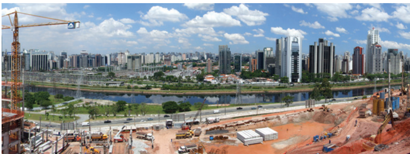
1 y 2 - Vista de las paredes atirantadas de un futuro subsuelo. 3 - Vista panorámica de las obras del complejo inmobiliario Cidade Jardim.
