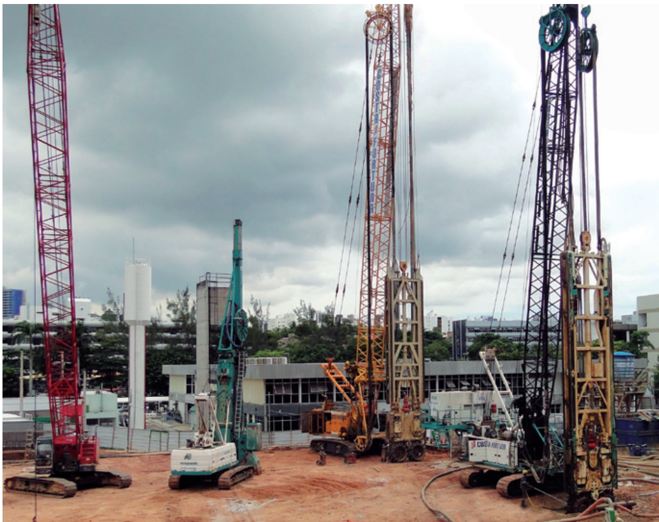
Conjuntos de gruas e hidrofresas para la ejecución de pilotes barrete en roca saneada.
