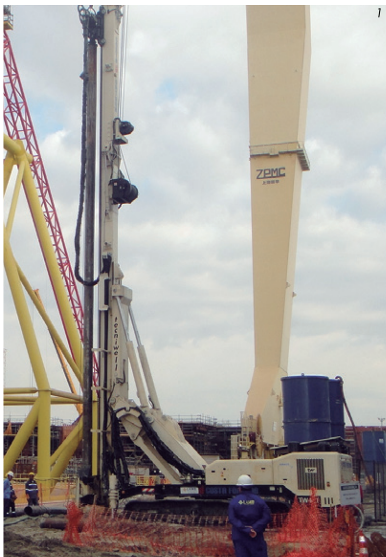
1. Ejecución de los pilotes raíz en roca
