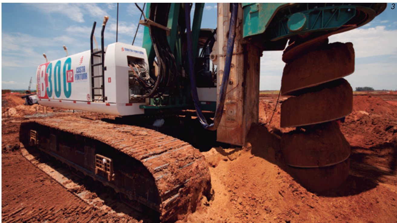
3 - Ejecución de pilote excavado y hélice continua.
