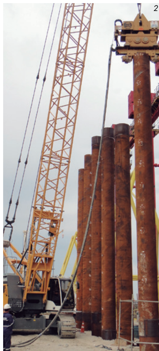
2. Anclaje de pilotes metálicos mediante uso del martillo vibratorio.
