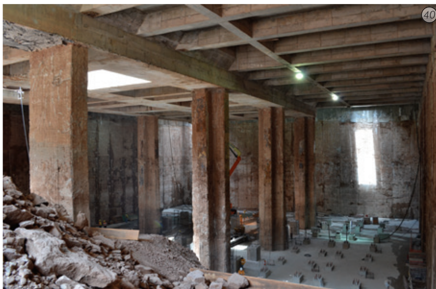
Figs. 38, 39 e 40 - Vistas do término das escavações e exposição de paredes diafragma e barretes, em plena atividade estrutural.
