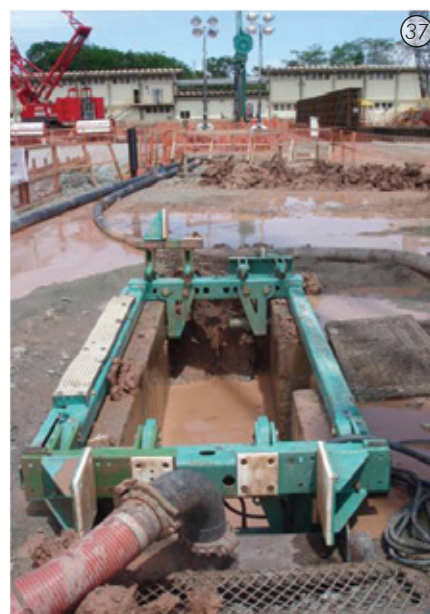
Fig. 37 - Detalhe da guia metálica da hidrofresa que proporciona maior nível de escoramento para centralizar e guiar a ferramenta.
