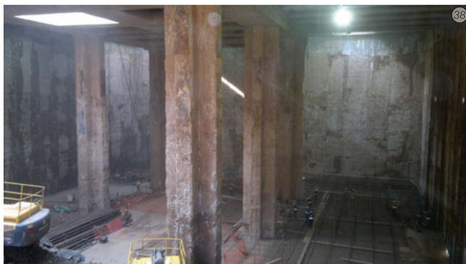
Figs. 38, 39 e 40 - Vistas do término das escavações e exposição de paredes diafragma e barretes, em plena atividade estrutural.
