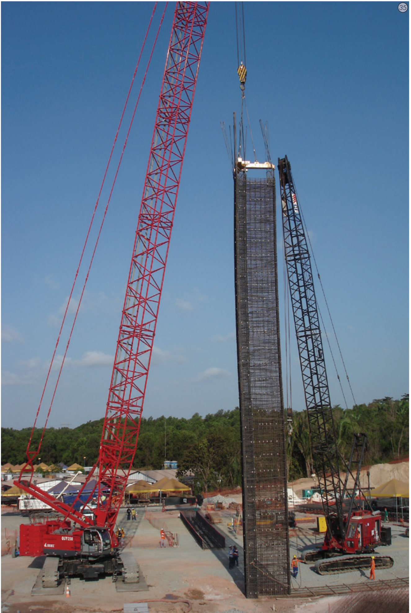
Fig. 35 - Lçamento de armadura com 43 m de extensão e peso de 43 tf verticalizada e pronta para introdução no furo.
