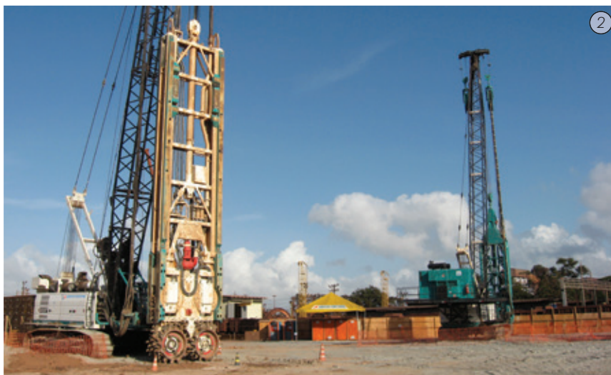
Fig. 2 - Obra em São Luiz, MA - Conjunto de hidrofresas Casagrande FD60 e FD30.
