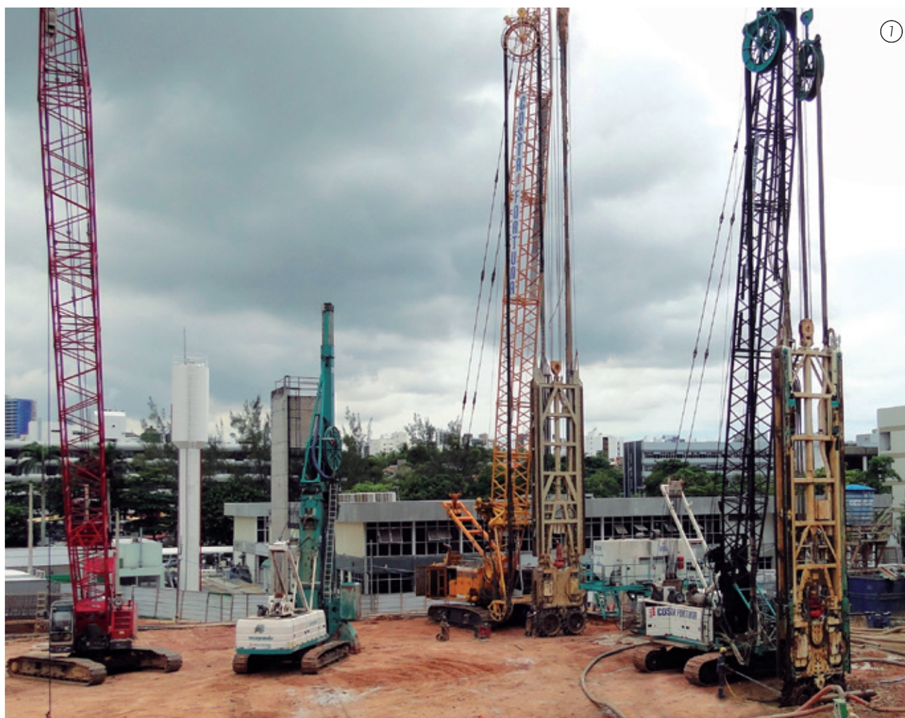
Fig. 1 - Conjuntos de guindastes e hidrofresas para execução de parede diafragma em rocha - Salvador - BA
