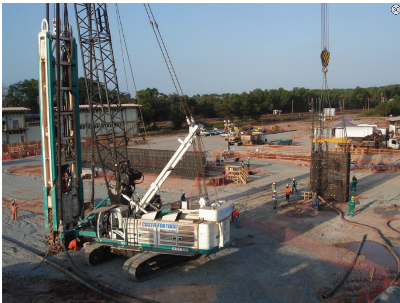
Fig. 30 - Vista do conjunto de hidrofresa e ferragem em "T" introduzida 35 m dentro de um furo.
