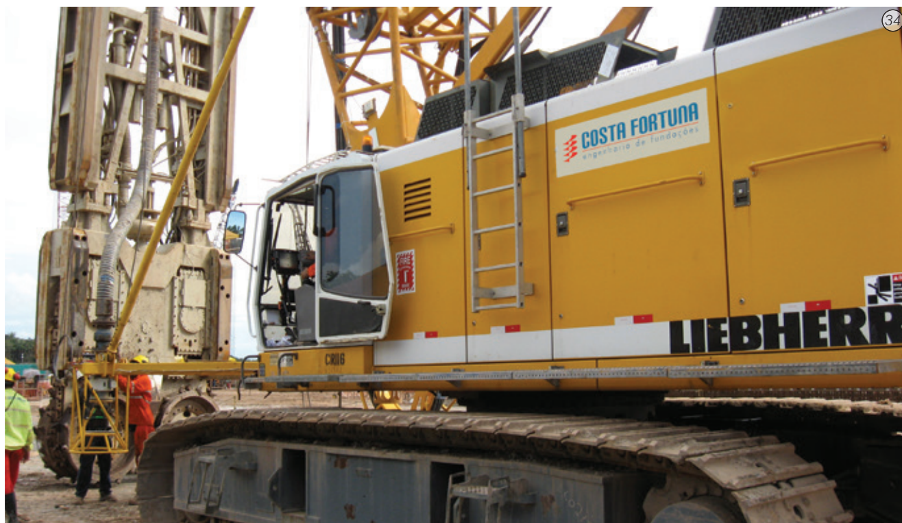
Fig. 34 - Guindaste sobre esteiras hidráulico de capacidade 120 ton e hidrofresa Casagrande FD60
