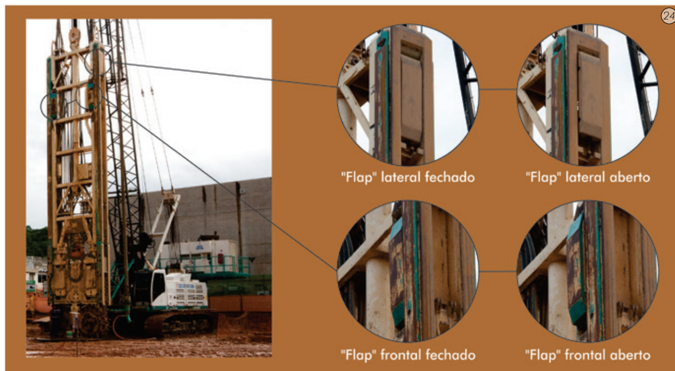
Fig. 24 - detalhe do dispositivo hidráulico - "flaps"
