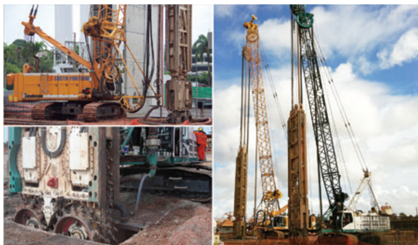
PAREDE DIAFRAGMA EM ROCHA COM USO DE HIDROFRESA
