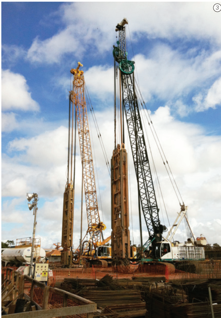
Fig. 3 - Obra em São Luiz, MA - Conjuntos de hidrofresas Casagrande FD60.
