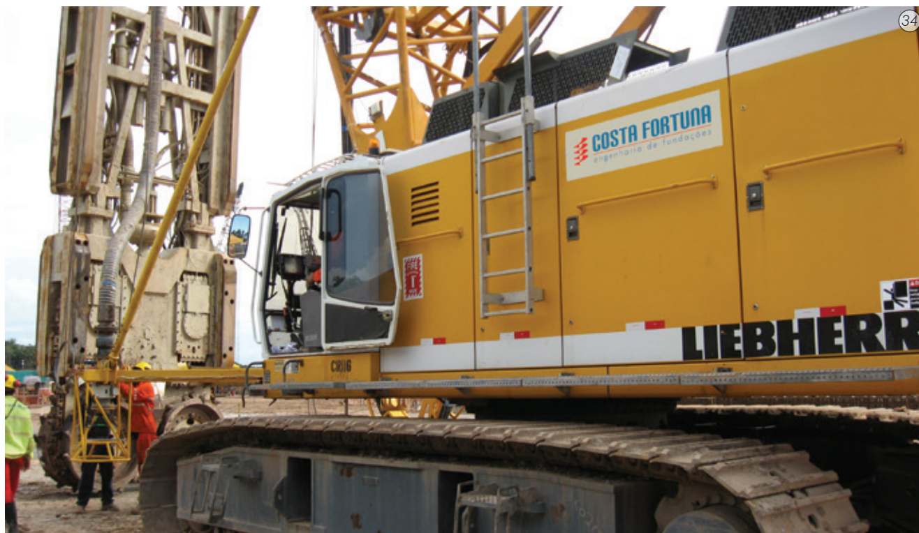
Imagen 34 - Grúa sobre las esteras hidráulicas con capacidad de 120 ton e hidrofresa Casagrande FD60.
