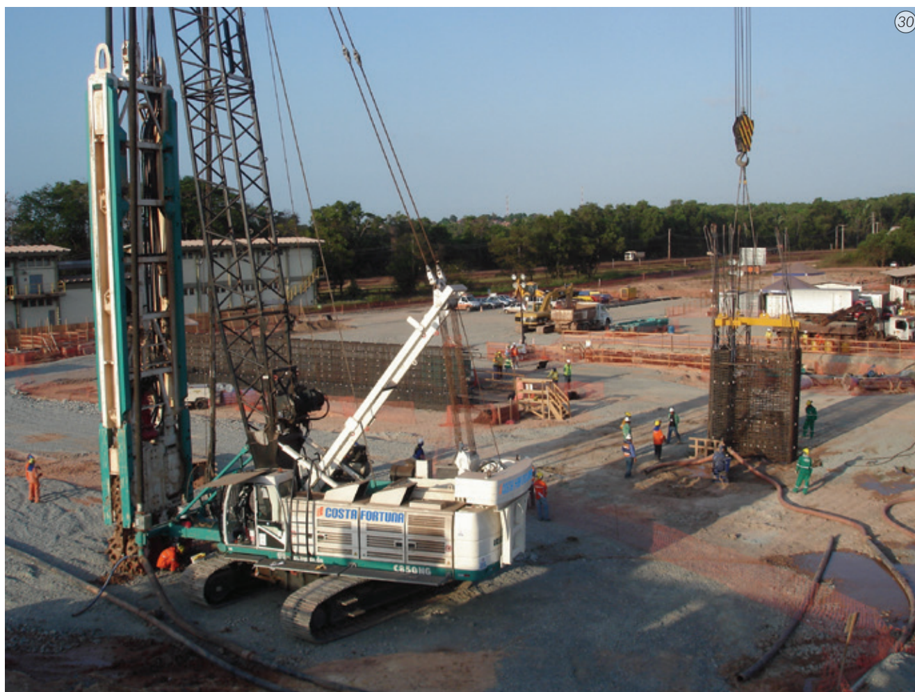
Imagen 30 - Vista del conjunto de hidrofresa y armaduras en "T" introducido 35m dentro del agujero.
