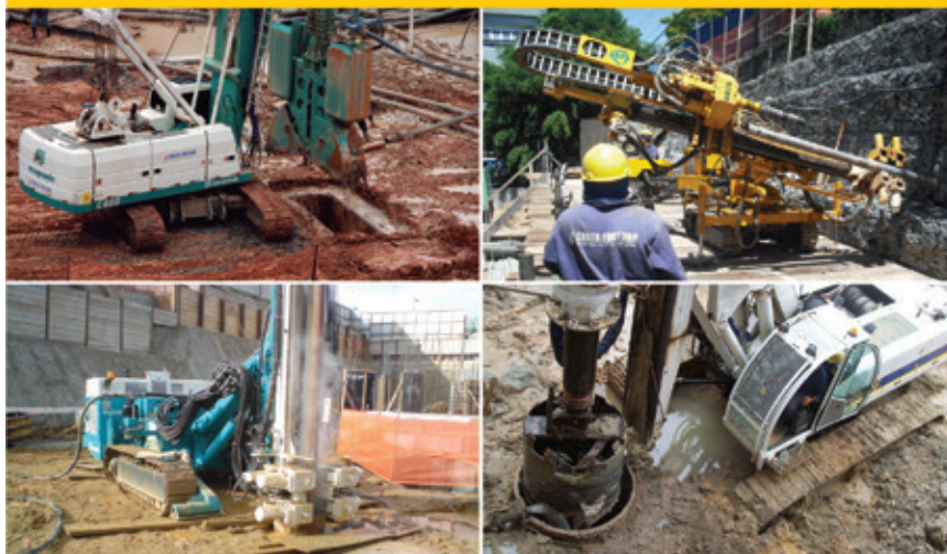
FUNDACIONES ESPECIALES Y GEOTECNIA
