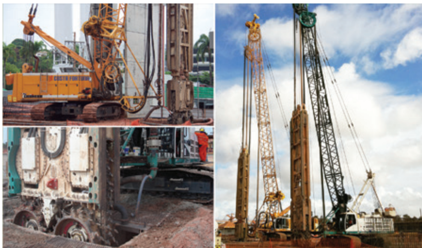
MURO DIAFRAGMA EN ROCA MEDIANTE USO DE HIDROFRESA
