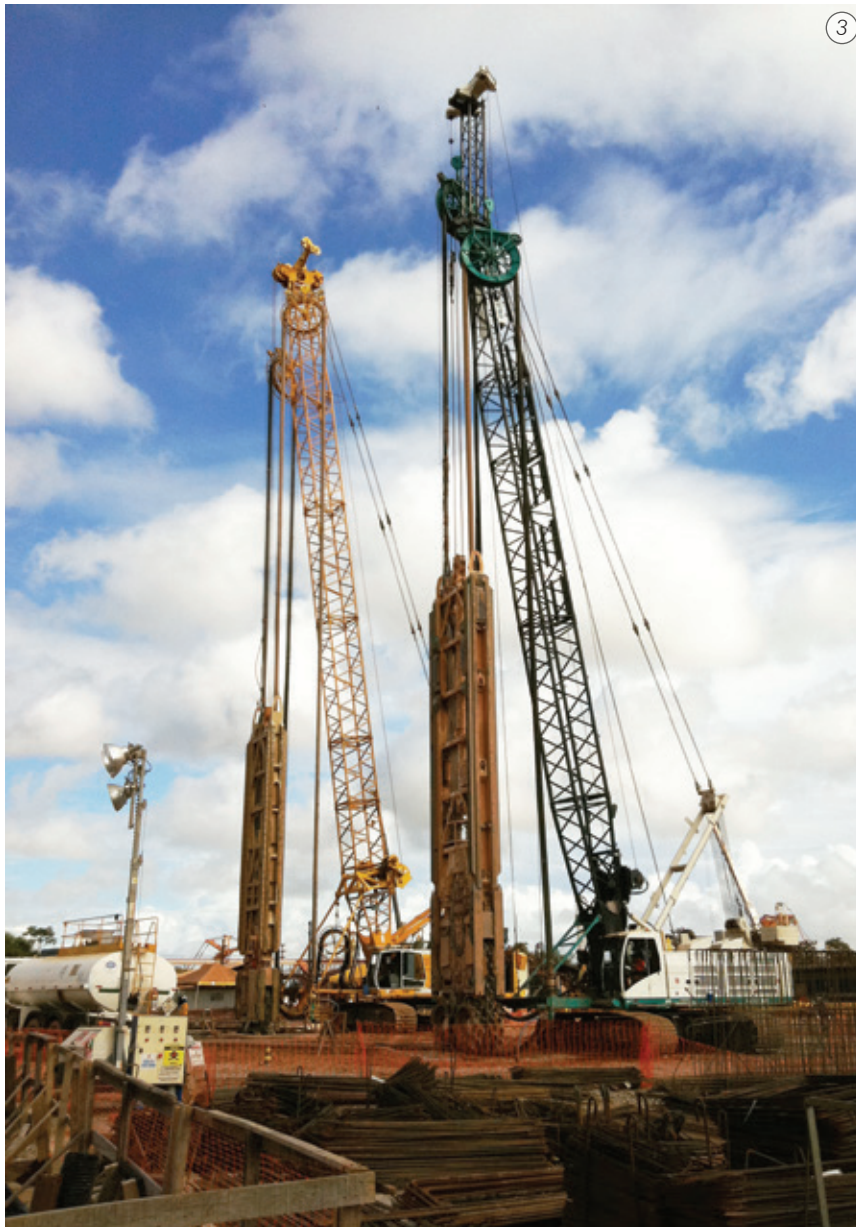
Imagen 3 - Obra en San Luiz, MA - Conjunto de hidrofresas Casagrande FD60.
