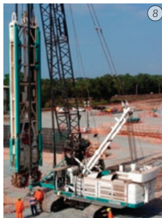
Imágenes 6 y 7 - Conjuntos de clam shell mecánicos e hidráulicos de alta precisión, Imágenes 8 y 9 - Conjuntos de hidrofresas Casagrande FD60 acopladas a grúas de alta potencia.
