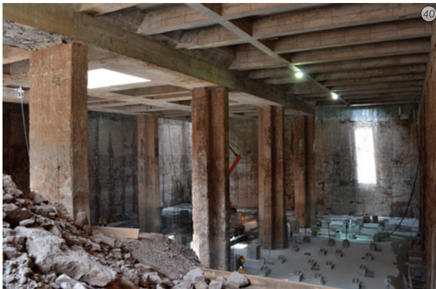
Imagen 38, 39 y 40 - Fotos del fin de las excavaciones y exposición de muros diafragma y barretes, en plena actividad estructural.
