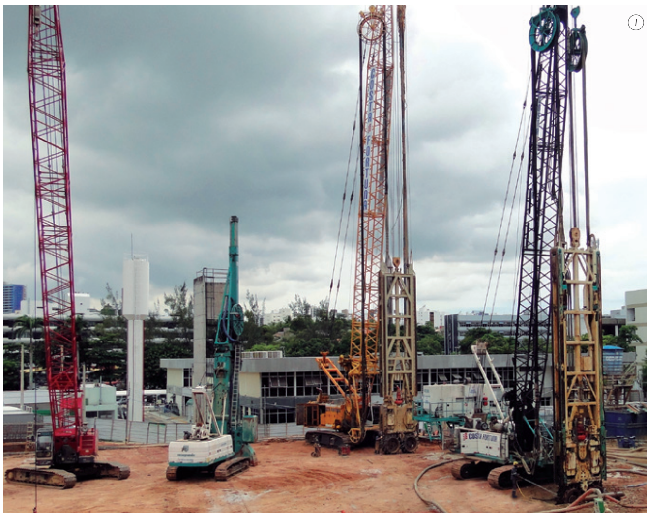
Imagen 1- Conjuntos de gruas e hidrofresas utilizadas para la construcción de muro diafragma en roca - Salvador - BA
