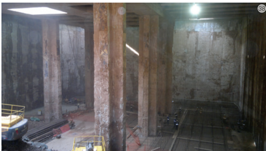
Imagen 38, 39 y 40 - Fotos del fin de las excavaciones y exposición de muros diafragma y barretes, en plena actividad estructural.
