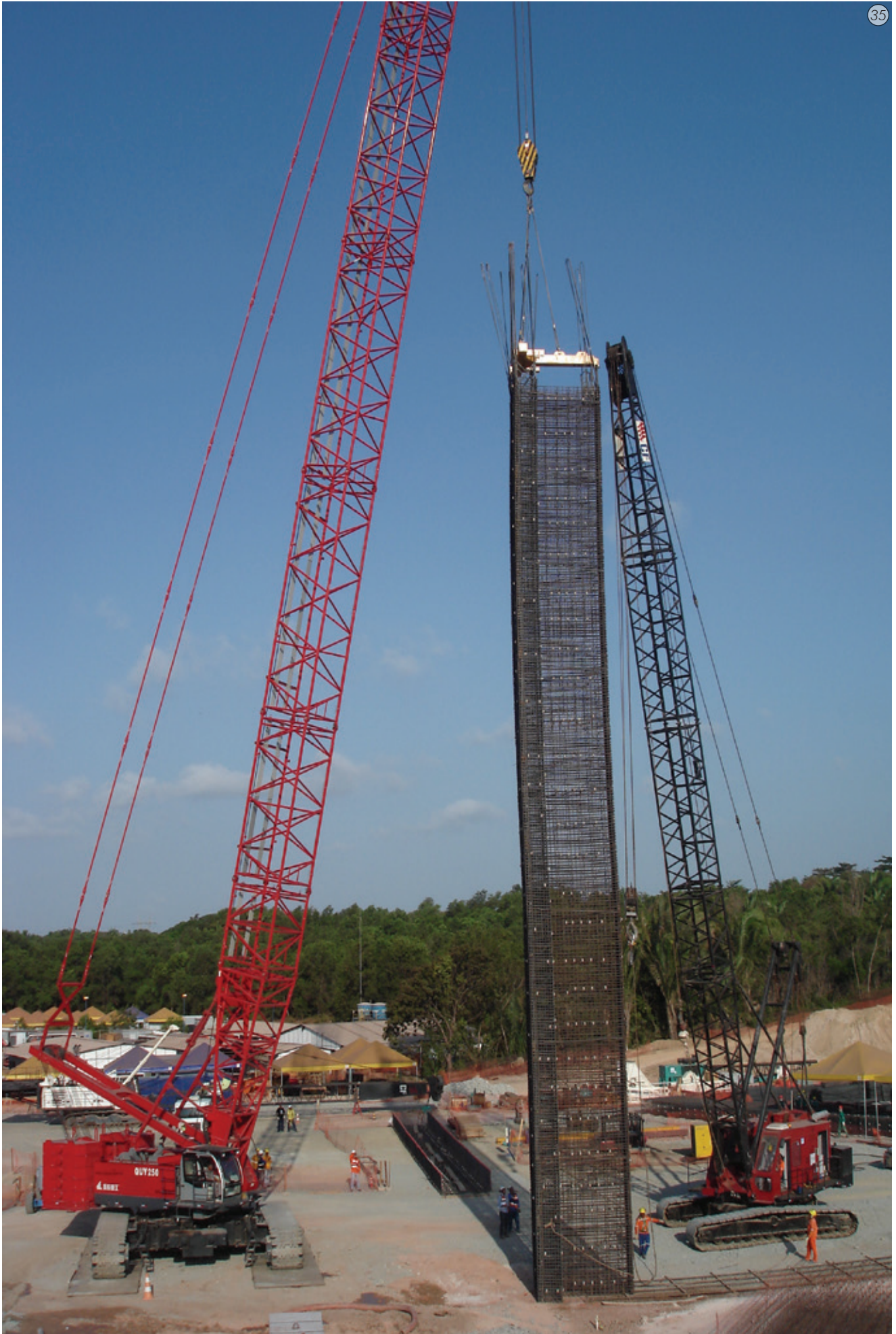
Imagen 35 - Izamiento de armadura con 43m de extensión y peso de 43tf verticalizada y lista para introducción en el agujero.
