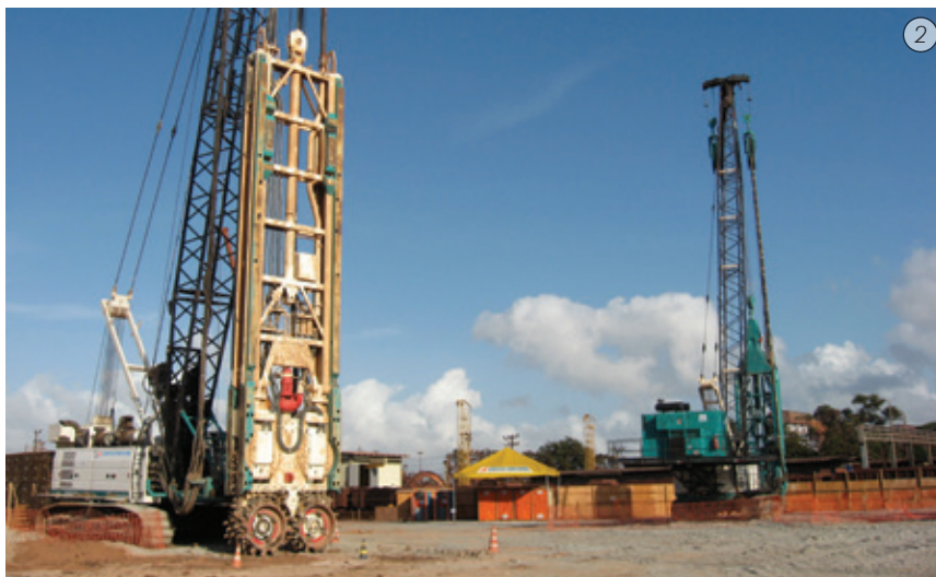
Imagen 2 - Obra en São Luiz, MA - Conjunto de hidrofresas Casagrande FD60 y FD30
