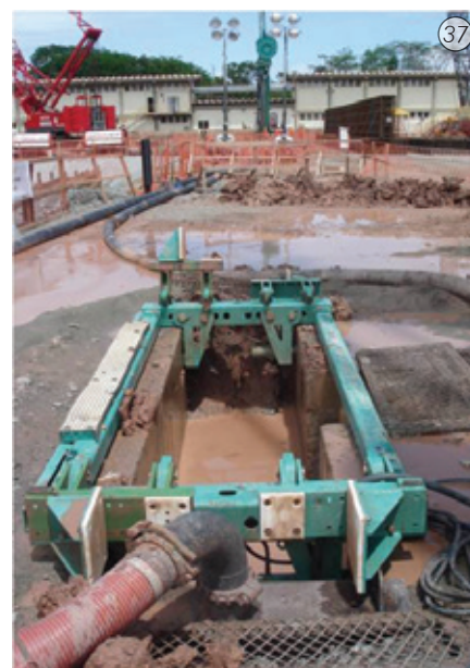
Imagem 37 - Detalle de la guía metálica de la hidrofresa que proporciona un mayor nivel de arrimo para centralizar y guiar la herramienta.
