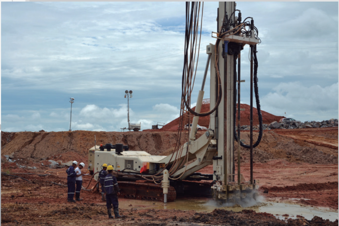
Ejecución de Jet Grouting con barras triples - Pará/Brasil
