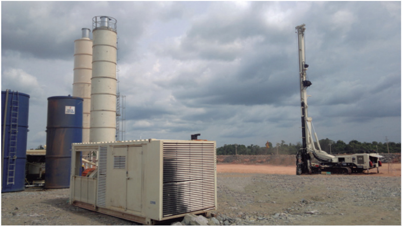
Conjunto de equipos para ejecución de Jet Grouting - Pará/Brasil.
