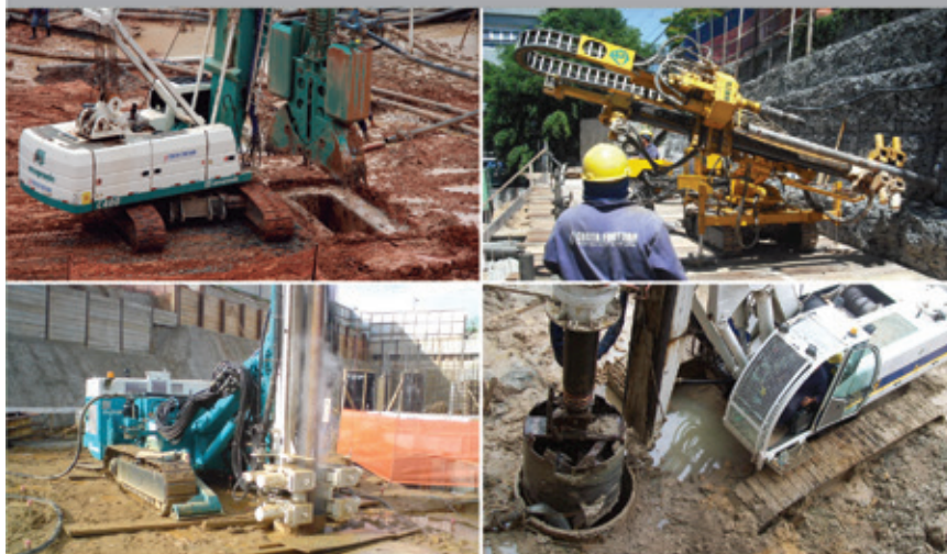
FUNDACIONES ESPECIALES Y GEOTECNIA
