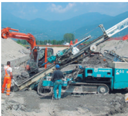
Fig. 11 - Execução de um tirante tipo MiniJET® em território europeu.
