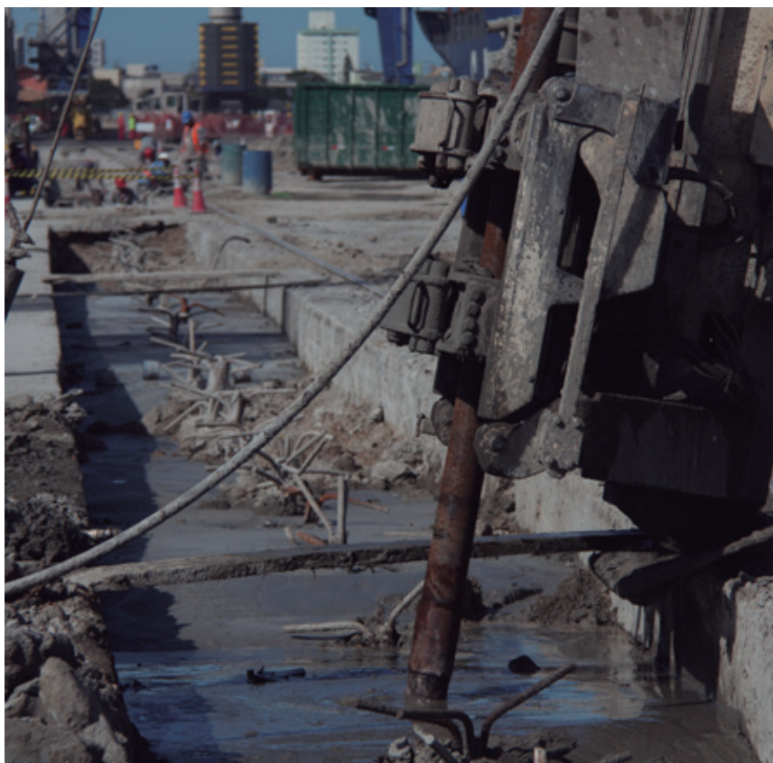
Fig. 41 e 42 - Canteiro de obra no porto em Santa Catarina - Brasil.
