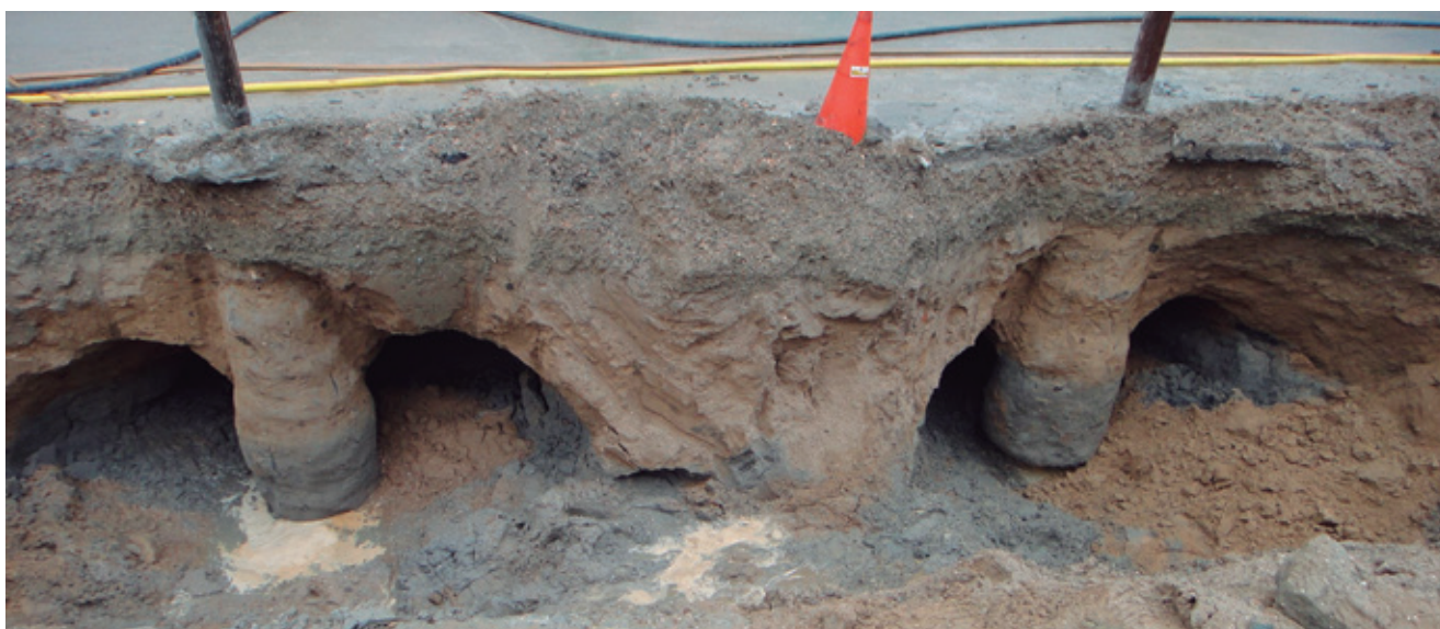
Fig. 37 - Vista de duas estacas teste realizadas com parâmetros diferentes de injeção.
