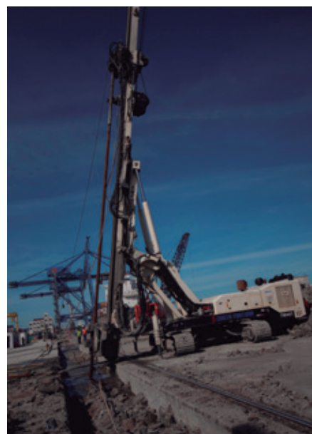
Fig. 12 - Execução de um estaca tipo MiniJET® em território brasileiro.
