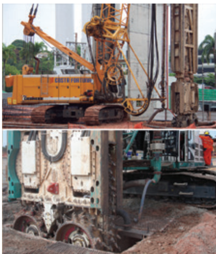
PAREDE DIAFRAGMA EM ROCHA COM USO DE HIDROFRESA
