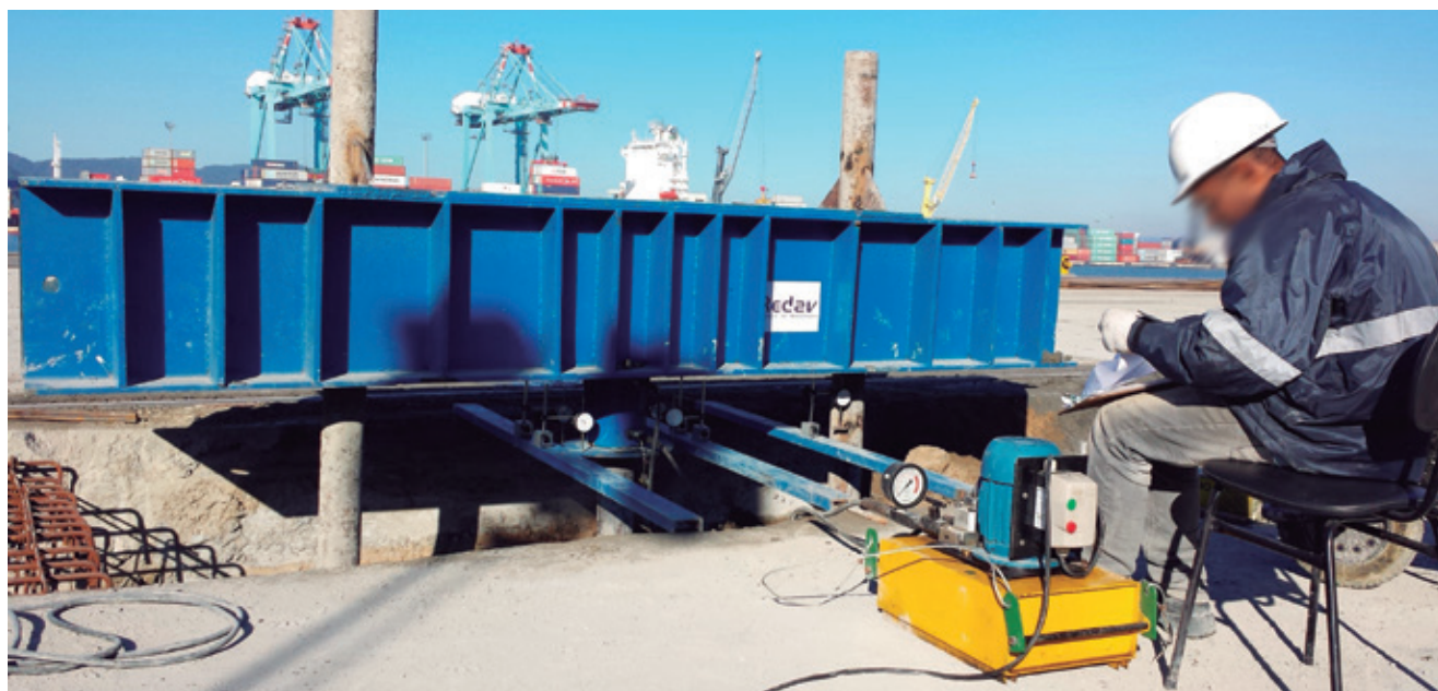
Fig. 38 - Execução de uma prova de carga estática à compressão e tração.
