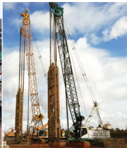
PAREDE DIAFRAGMA EM ROCHA COM USO DE HIDROFRESA
