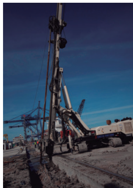
Imagen 12 - Ejecución de un pilote tipo MiniJET en territorio brasileño.
