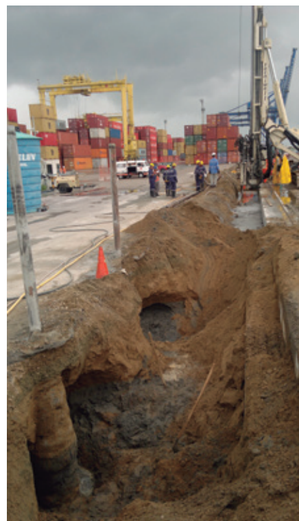
Imagen 36 - Exhumación de pilotes test ejecutados.
