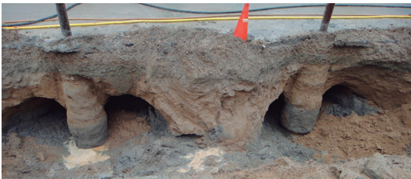
Imagen 37 - Vista de dos estacas test realizadas con parámetros diferentes de inyección.
