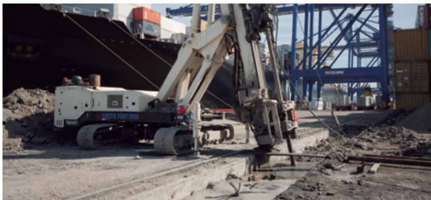
Imagen 35 - Ejecución de columnas miniJET® inclinadas mediante el uso de una perforadora con tecnología punta para servicios especiales.
