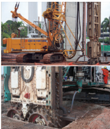
MURO DIAFRAGMA EN ROCA MEDIANTE USO DE HIDROFRESA
