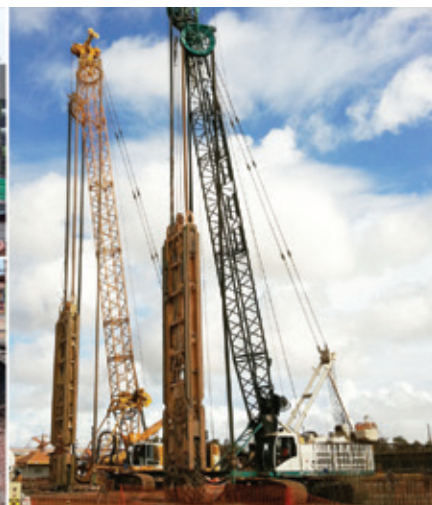
MURO DIAFRAGMA EN ROCA MEDIANTE USO DE HIDROFRESA
