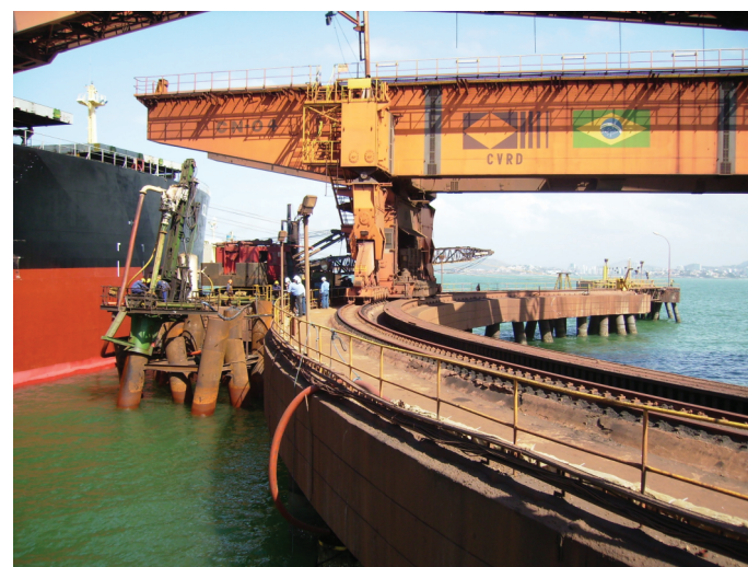
Recuperação do dolphin de atracação - Porto de Tubarão - ES
